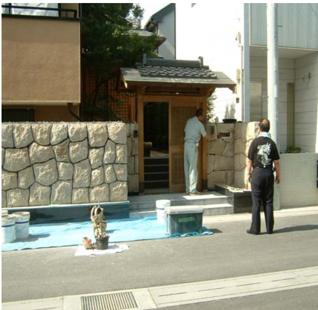
石張り工事最後の 仕上げ段階
