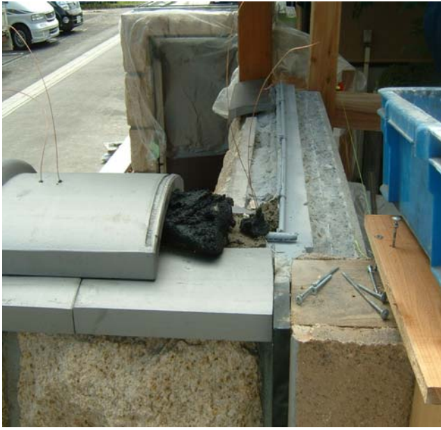
塀の上の笠木瓦工事中
