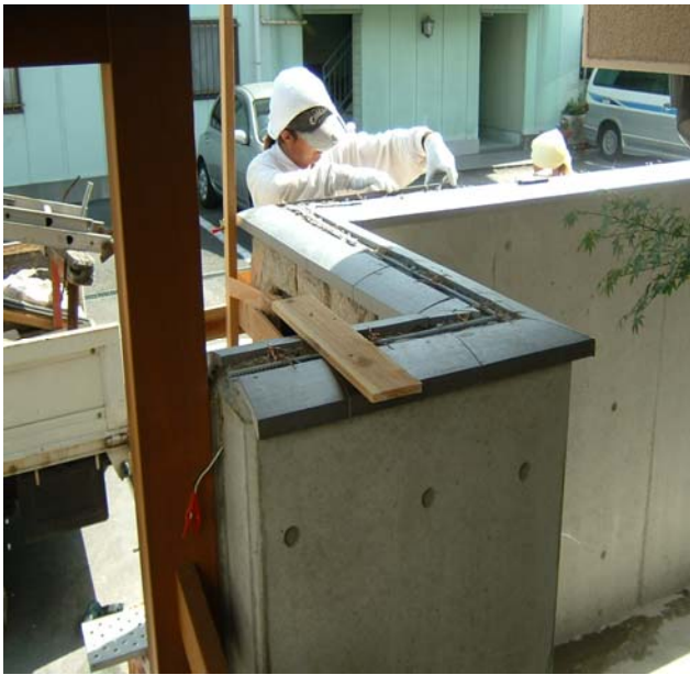
塀の上笠木瓦工事中
