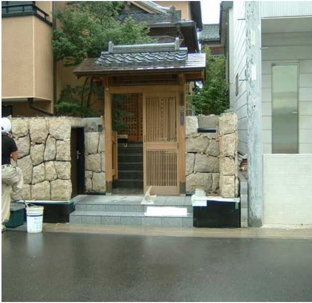
新規塀の石張り工事
