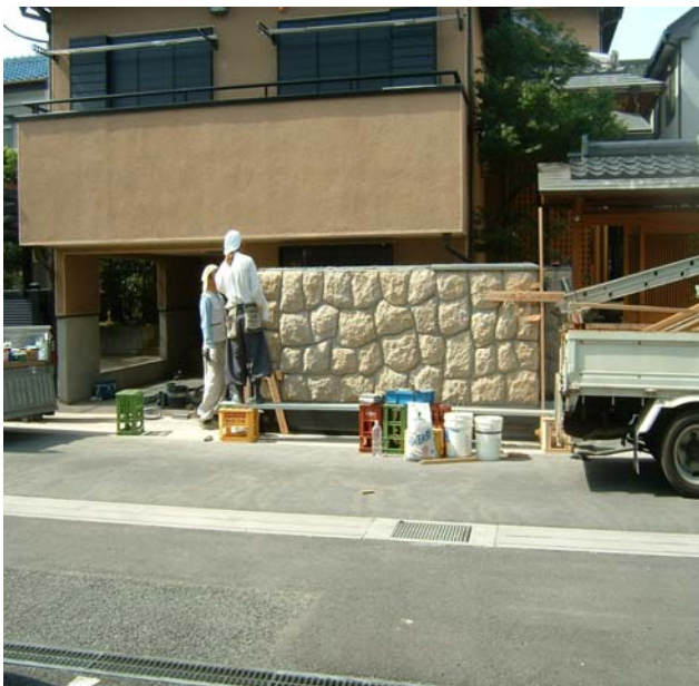
塀の上笠木瓦工事中
