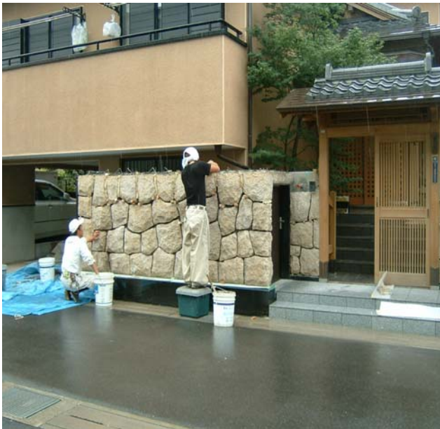
新規塀の石張り工事
